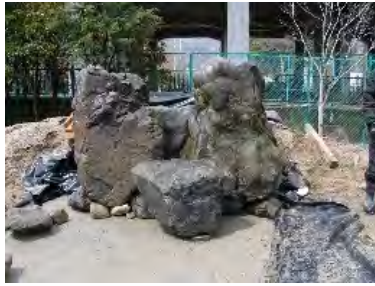
2 段目：水落ち石据付
