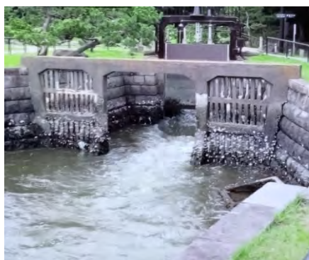
図ー1 潮入の池の水を調節する水門 (浜離宮恩賜庭園)
