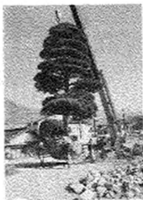
図 クレーンによる 引上げ
