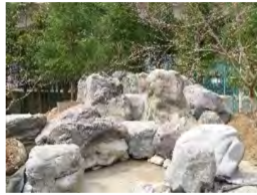
2 段目：滝添え石据付他
