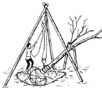
・図 チェーンブロックによる引上げ
